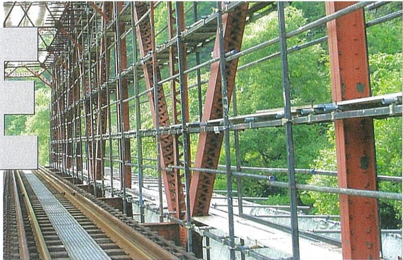
鉄道の橋梁の営業線近接工事（電化区間）では、基本的にUEXCのFRP足場材が使用されています。
